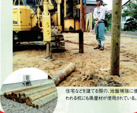
住宅などを建てる際の、地盤補強に使用される木にも県産材が使用されている。
