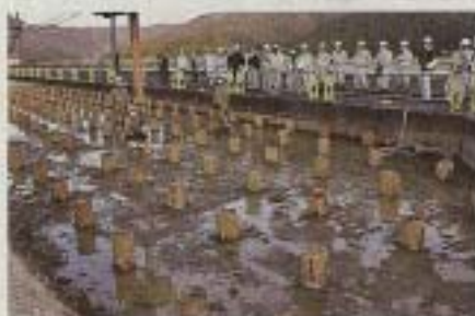
輪中堤整備のため県産間伐杉の基礎杭を3本連結して打設する工事現場＝15日、小浜市江古川
