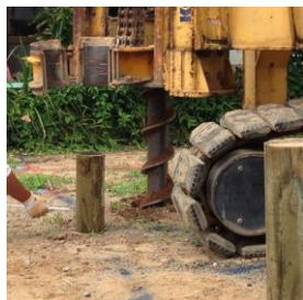
【環境パイル(S)工法】
